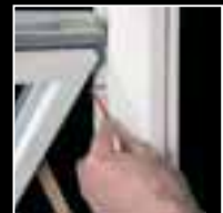
3. Stilling á viðnámshemlum. Rennikubburinn í viðnáms-hemlum er hertur með sex-kanti eins og sýnt er á myndinni.
