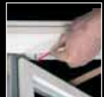
Stilling á viðnámshemlum. Rennikubburinn í viðnáms-hemlunum er hertur með sexkanti eins og sýnt er á myndinni.
